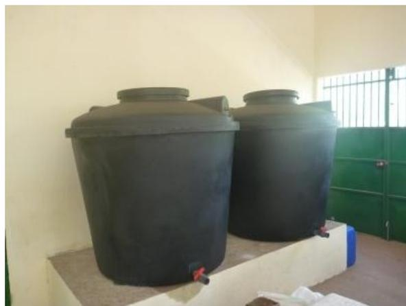
Figure 24 : Cuves Fofy en caoutchouc dur à Teriya Bugu d'une capacité de 1000 litres
