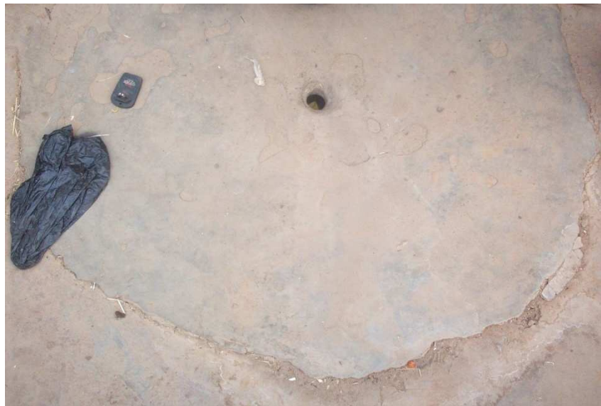
Figure 78: Puits perdu de cour intérieure
