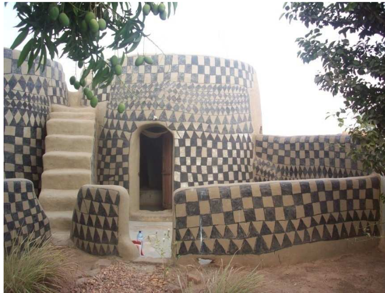
Figure 31: Enduit au goudron en dehors de la concession
