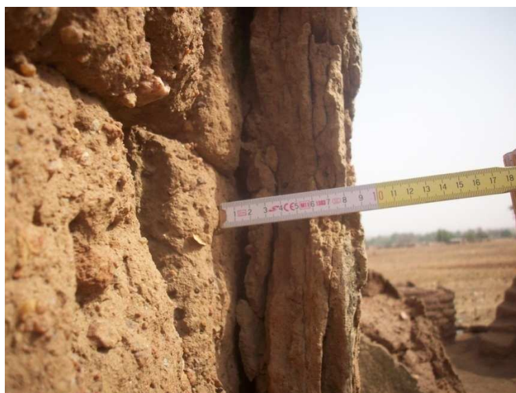
Figure 73: Epaisseur d'une couche d'enduit sur une ancienne case
