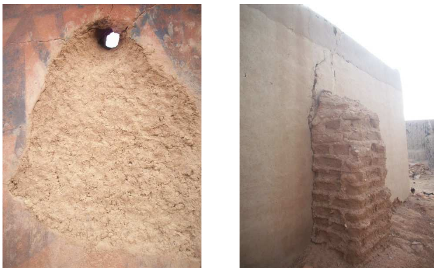
Figure 61: Autres pathologies. A gauche, évacuation d'eau. A droite: contrefort
