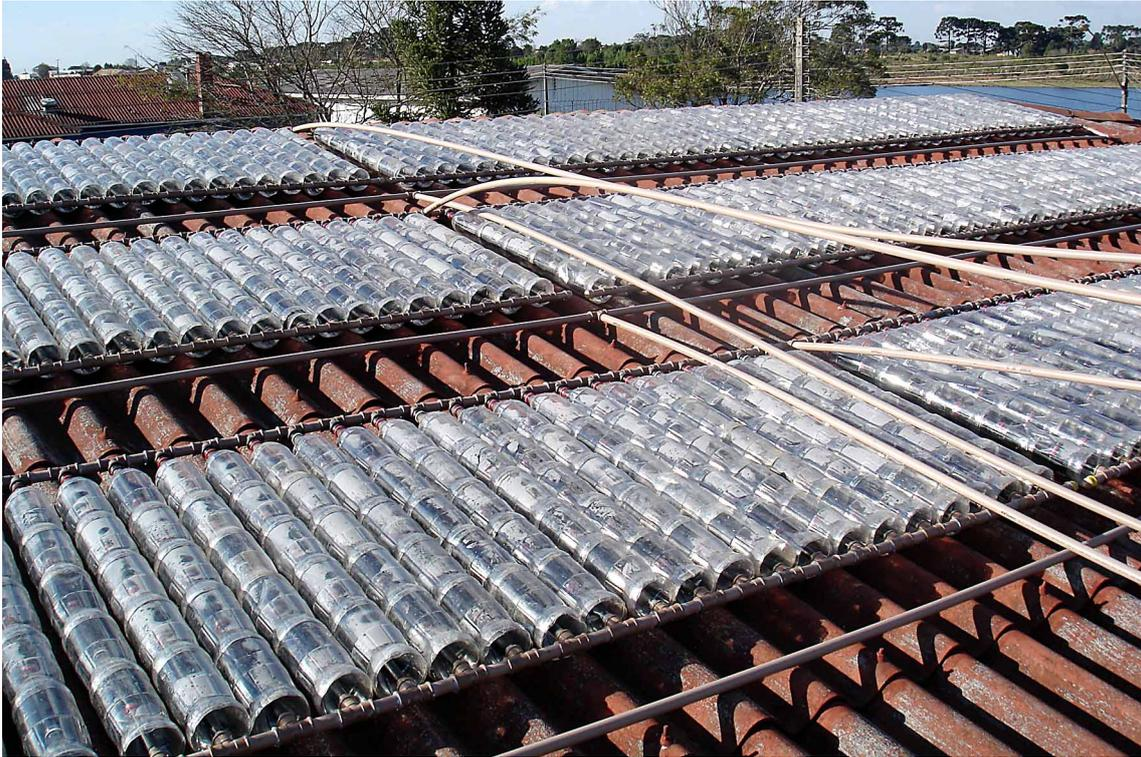
FIGURE 5 – Capteur PET installé sur le toit d’une caserne de l’armée brésilienne (Palmas, état du Paraná, Brésil). Le système, dimensionné pour fournir de l’eau chaude à 50 soldats, emploie 1800 bouteilles PET et 1500 cartons Tetra Pak. Photographie : SEMA.
