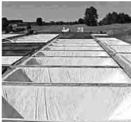
Photo 3.1 : Bâches en PVC pour le stockage d'eau
