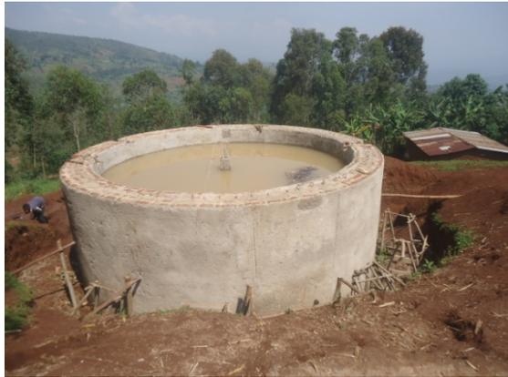
La mission confiée est purement technique. 3 réservoirs cylindriques doivent être dimensionnés sur base de contraintes qui seront spécifiées par le commanditaire de la mission
