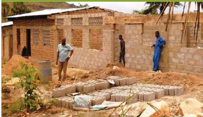
Travaux des gros œuvres. Octobre 2014
