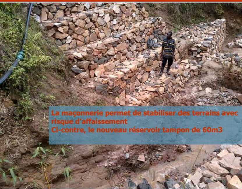
La maçonnerie permet de stabiliser des terrains avec risque d'affaissement
