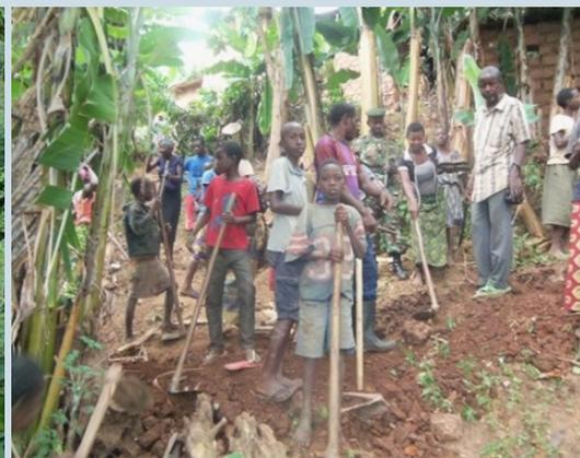
Les ouvriers ouvrent une tranchée pour des réparations et améliorer le réseau en plaçant une nouvelle conduite capable de prendre tout le débit.
