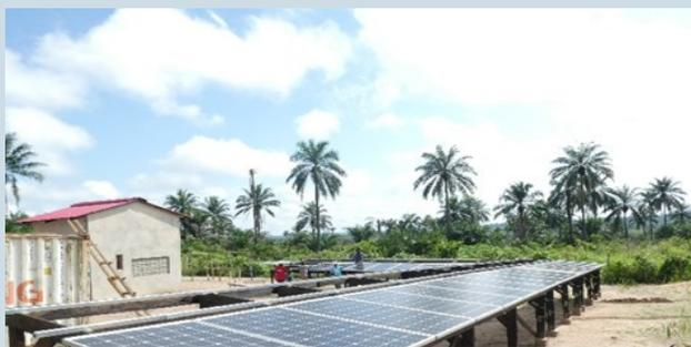
**Les 56 panneaux photovoltaïques. A gauche un des 4 conteneurs et le bâtiment du GÉ de secours.**
