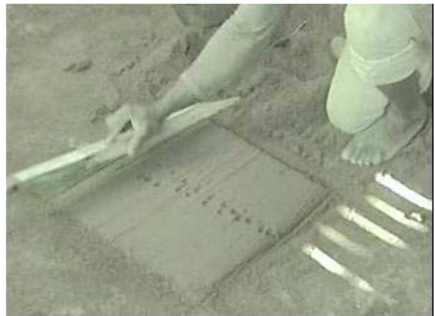
**Figure 15 : Réalisation d'un lit de sable de 3 à 4 cm d'épaisseur et de surface supérieure à celle du châssis. Ce lit de sable fera donc office de partie inférieure du moule.**
